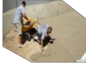
7- Havuz İç Taban Yapımı
